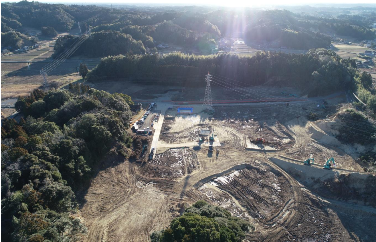
令和6年1月26日撮影 伐採工事、造成工事
