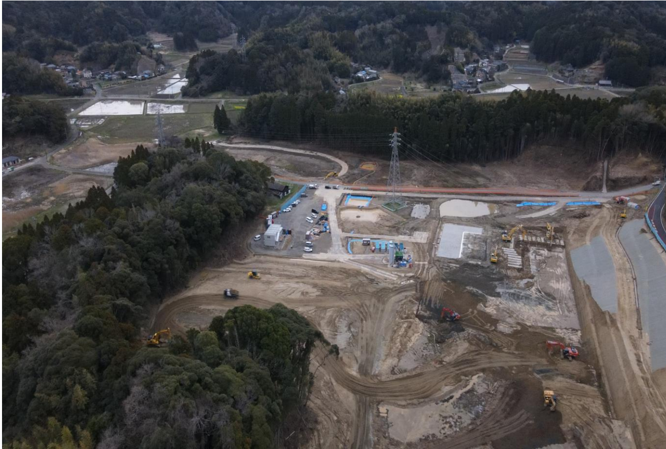
令和6年3月28日撮影 造成工事、法面工事、地盤改良工事
