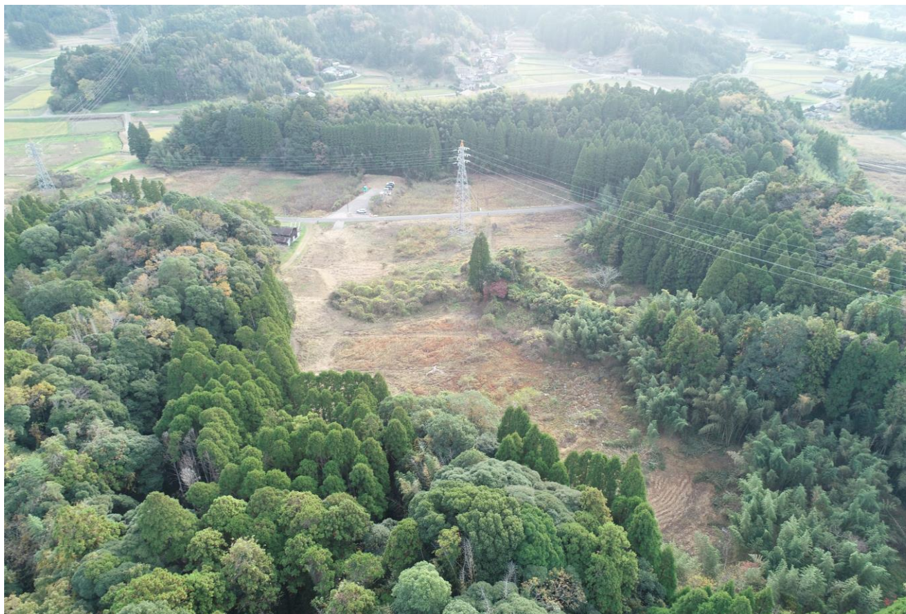
令和5年11月30日撮影 除草工、現地測量
