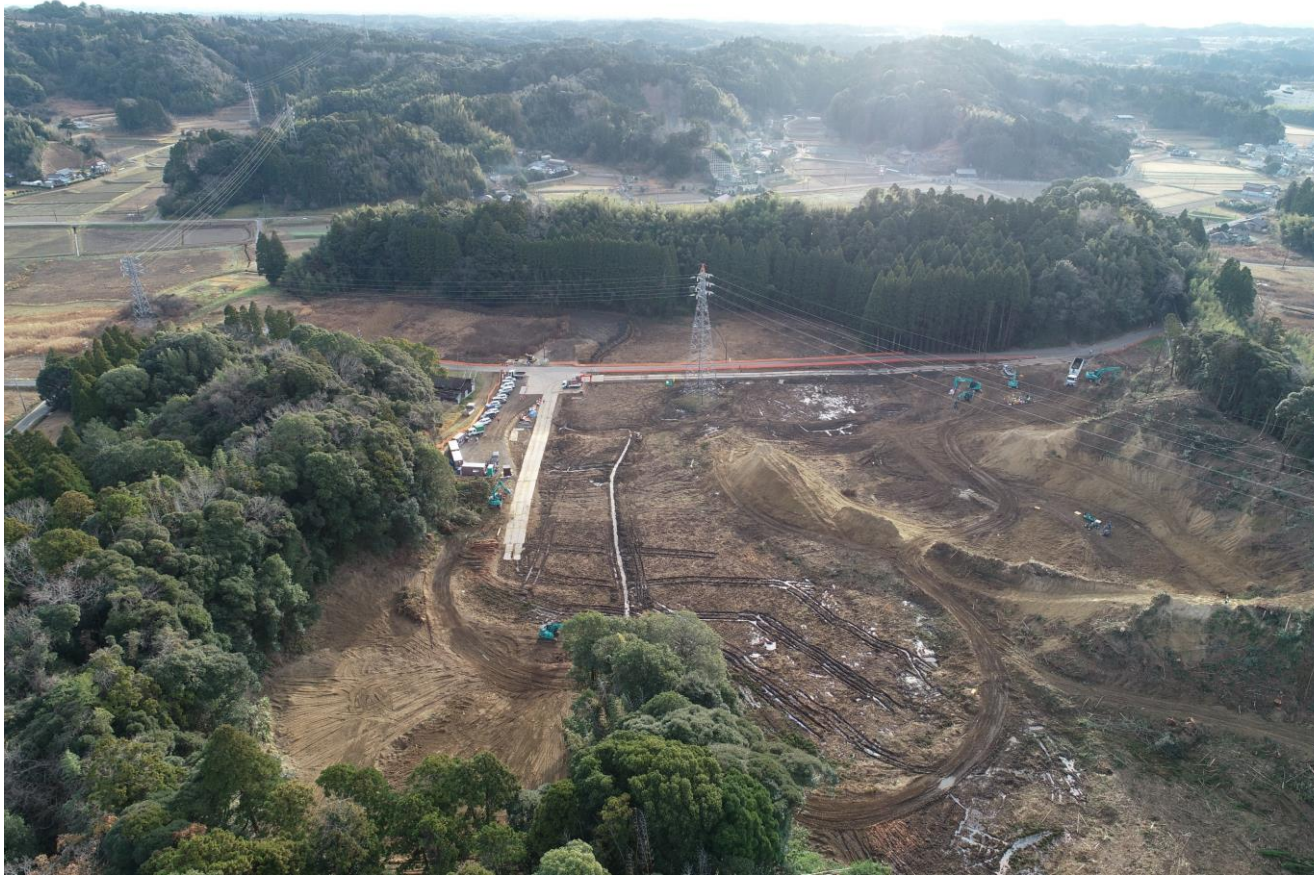
令和5年12月27日撮影 伐採工事、仮設工事
