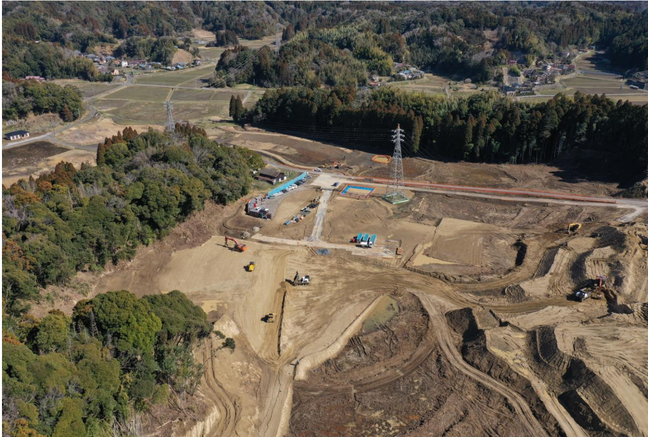
令和6年2月26日撮影 造成工事、法面工事
