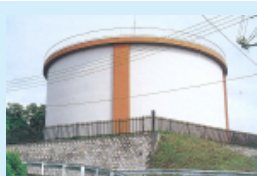
16 坂本配水場 (長南町)
