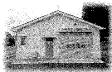
消防機庫新築工事
