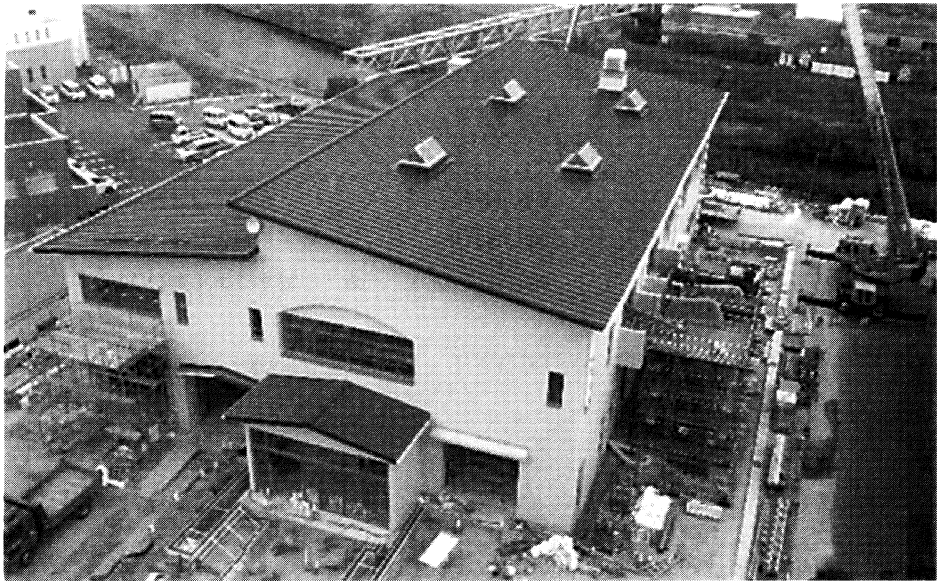
汚泥再生処理センター（平成30年7月竣工予定）
