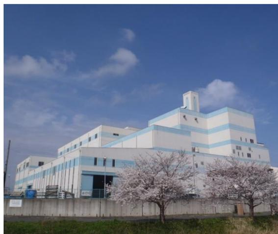
環境衛生センターごみ処理場は、ごみ焼却施設と粗大ごみ処理施設からなり、ごみ焼却時の余熱を利用して発電し、各処理施設に供給したのち余剰分を売電するほかに隣接する温水センターに熱供給を行っています。
