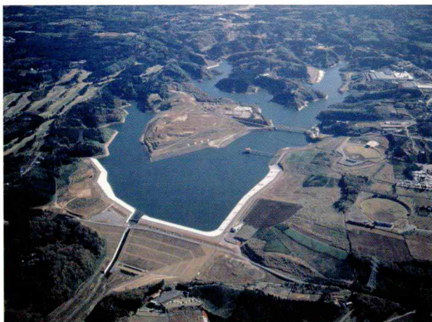
有貯水量960万mのアースダムで、房総導水路で送られてきた水を貯えます。 (水資源開発公団施設)
