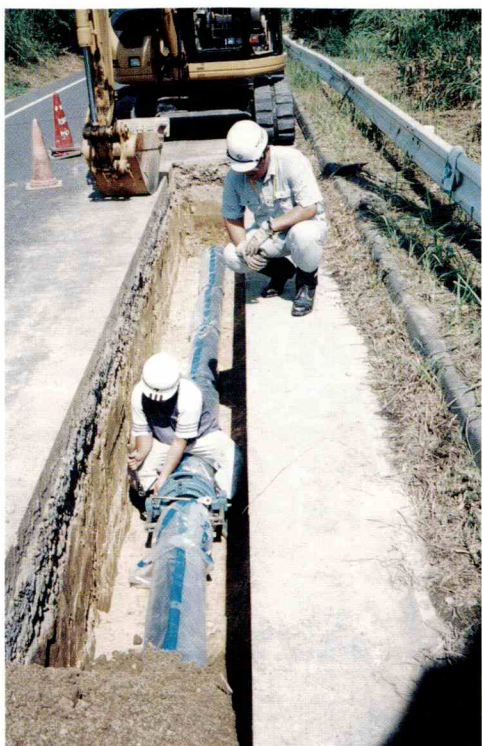
配水管布設工事
