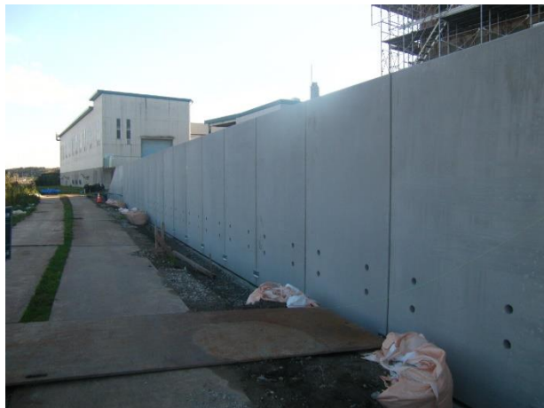
② L型擁壁設置
