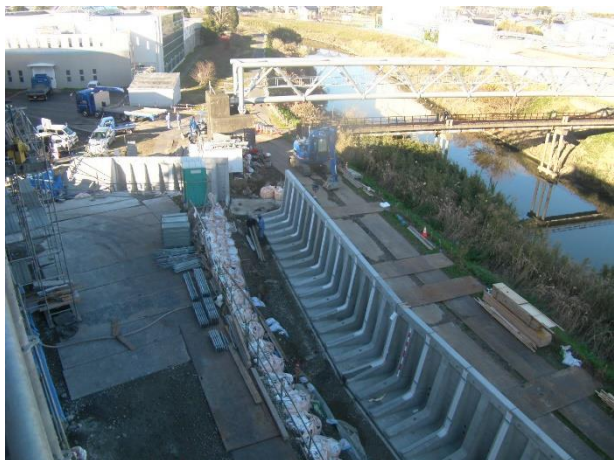
① L型擁壁設置
