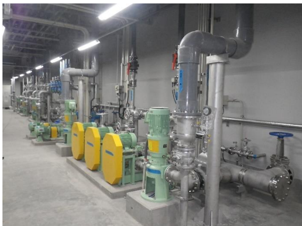
⑤ 機器据付
