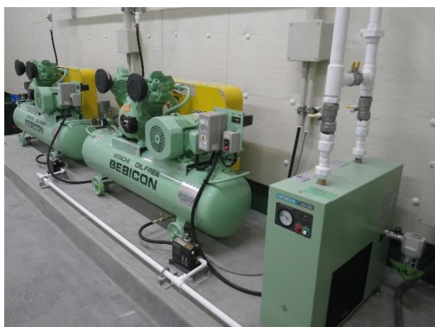
⑥ 機器据付
