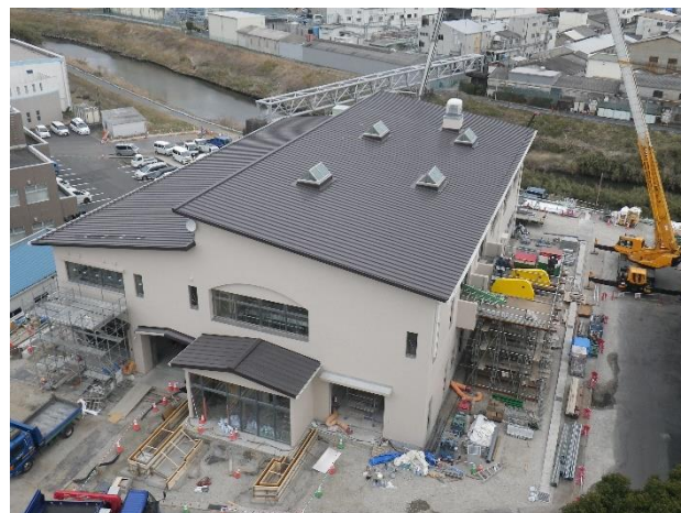
④ 屋根葺き (全景)
