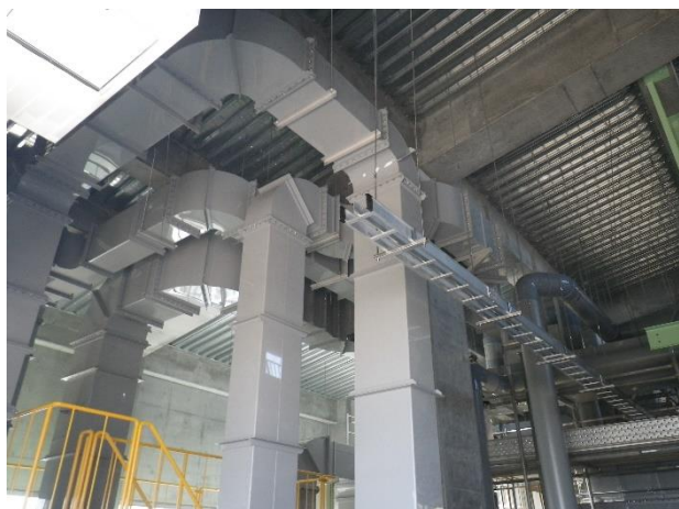
⑦脱臭ダクト布設
