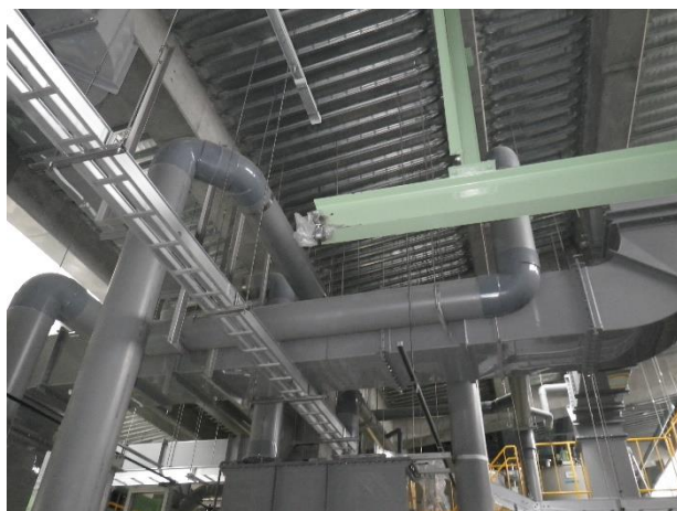
⑧脱臭ダクト布設
