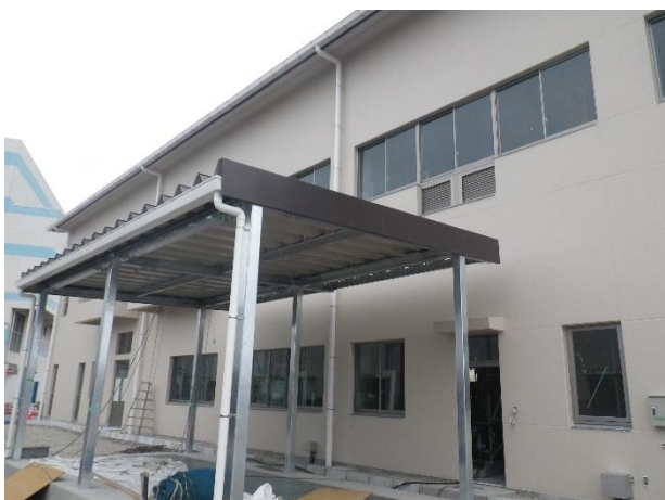
⑩トラックスケール屋根取付
