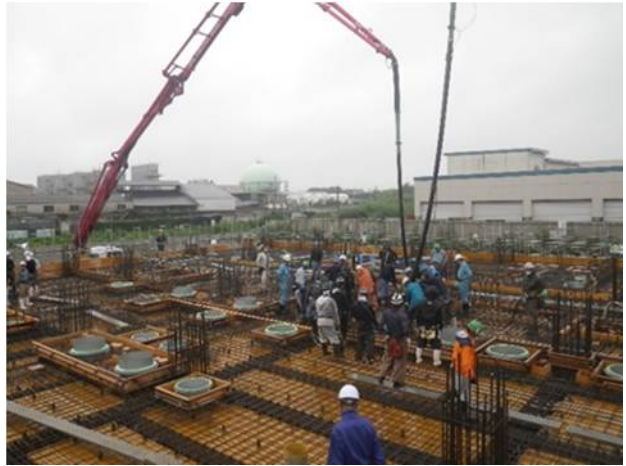
⑧コンクリート打設（1階梁・スラブ）（2）
