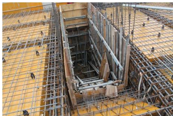
⑥配筋、型枠組立（1階梁・スラブ）(2)
