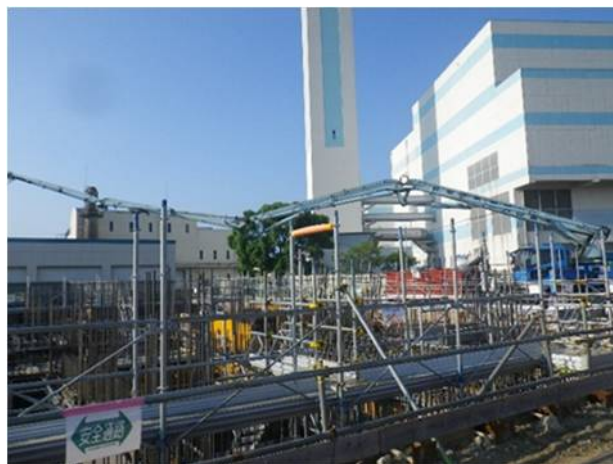
④コンクリート打設（地下1階柱・壁）(2)
