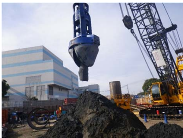
⑤ハマグラブで干渉する既成杭を撤去
