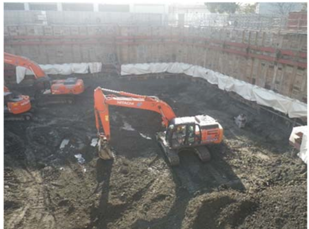
④地盤改良後、敷き鉄板を敷設
