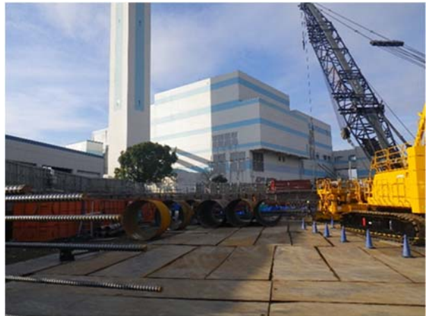
④地盤改良後、敷き鉄板を敷設
