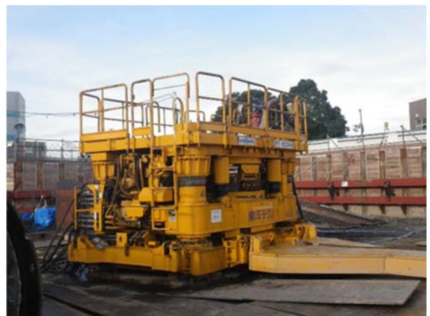
②杭打機の設置
