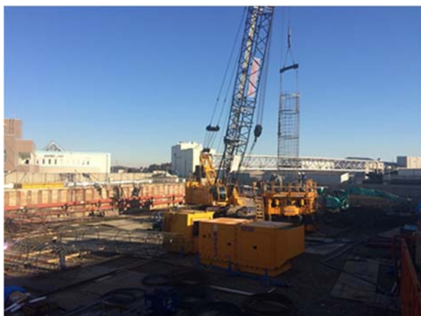
⑦鉄筋かごの建て込み
