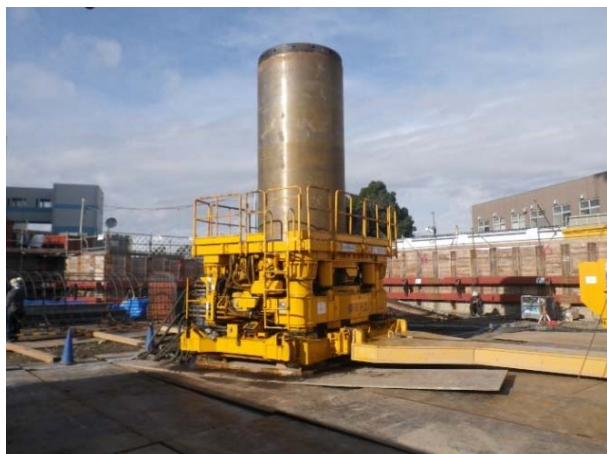
③ケーシングを回転させながら掘削
