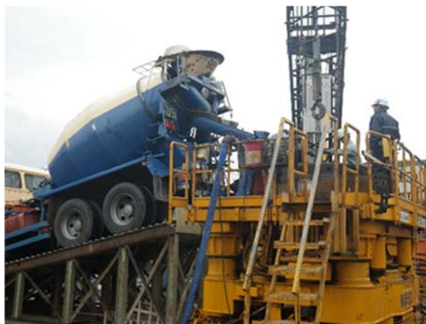
⑧コンクリート打設
