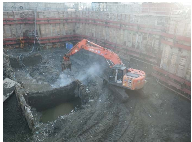
⑥ 4 次掘削の様子 (GL-7.7m)
