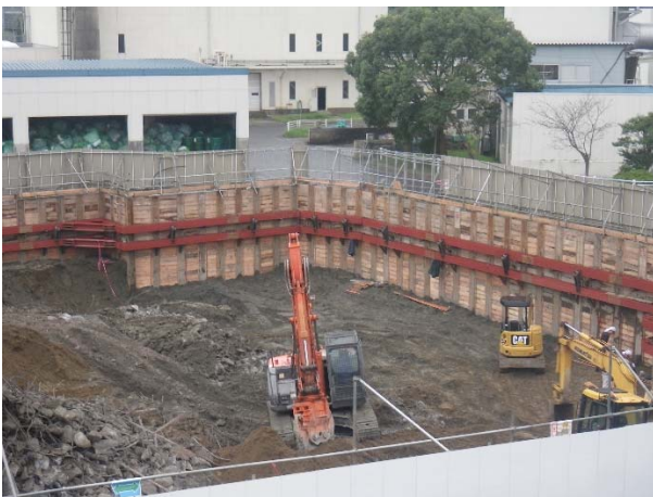
③ 2 次掘削の様子 (GL-3.7m)
