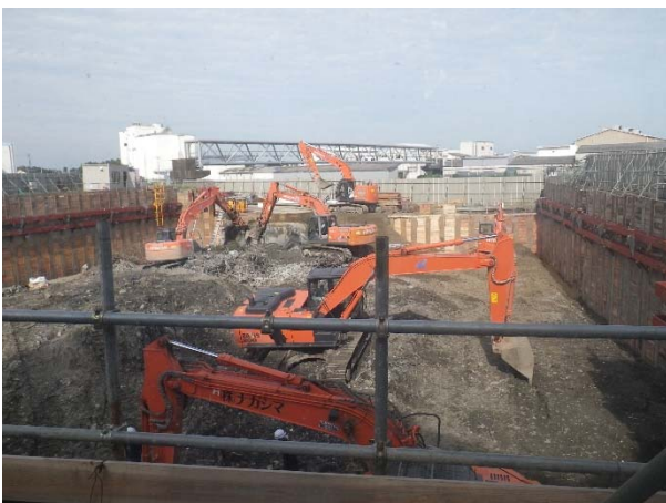
⑤ 3 次掘削の様子 (GL-5.7m) (2)
