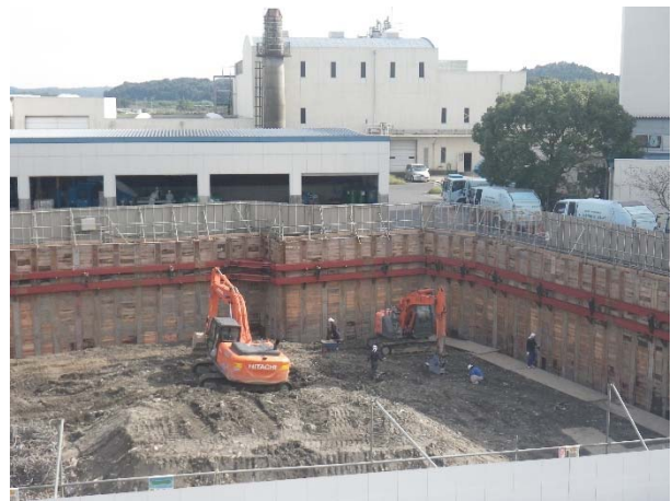
④ 3 次掘削の様子 (GL-5.7m) (1)
