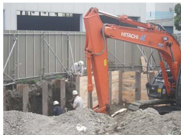
アースアンカー (1段目) を打設している様子
