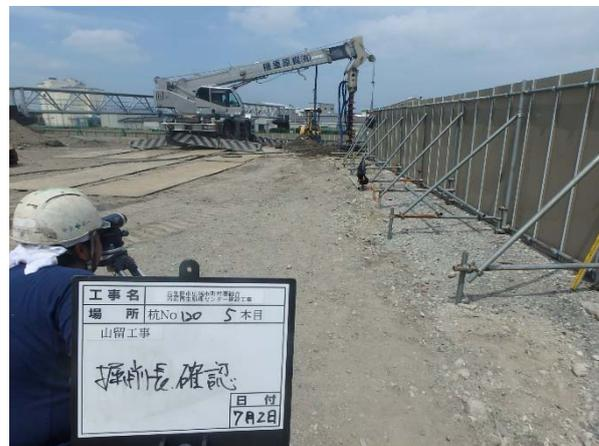
② 撤去工事 (1次掘削: -1.7m)
